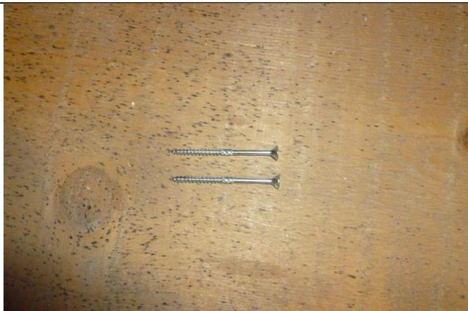
Die Aussenwände habe ich mit Holzsenkkopfschrauben befestigt. Die Schraubengrösse beträgt 4 x60mm
