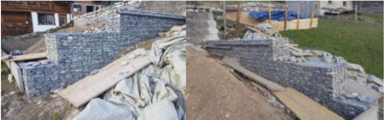
Abbildung 37 Steinkörbe dritte Reihe fertig (Melanie, 2017/18)
