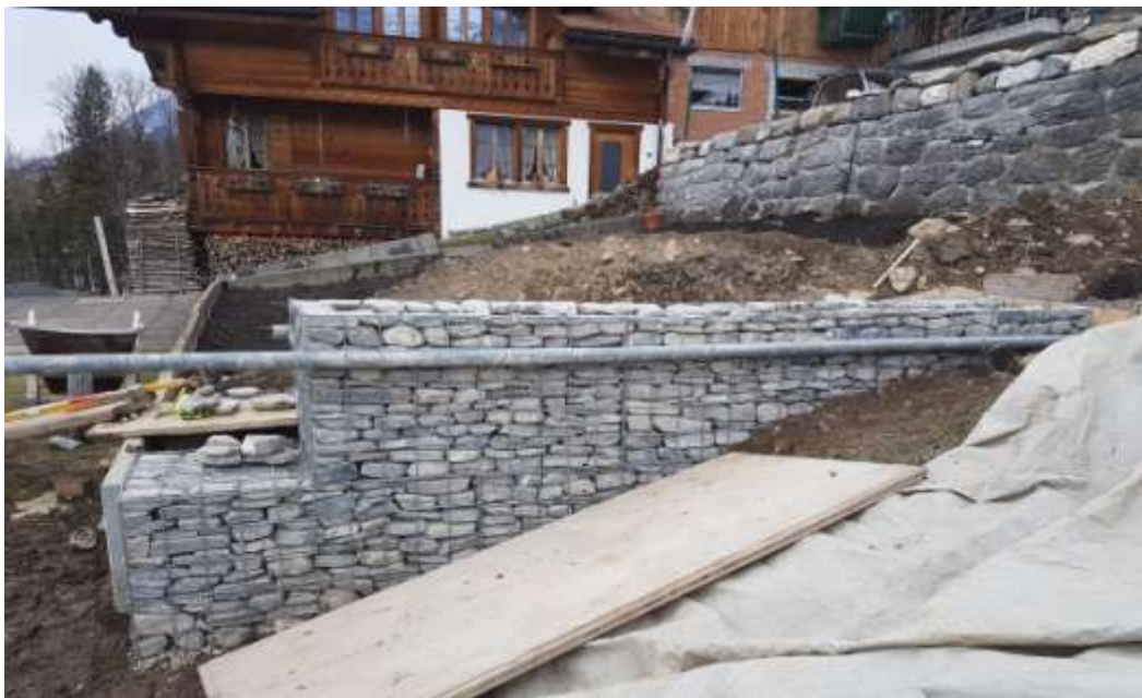
Abbildung 35 Steinkörbe zweite Reihe fertig geschichtet (Melanie, 2017/18)
