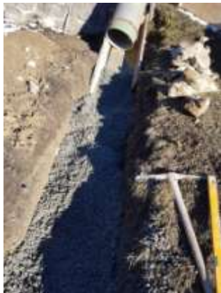
Abbildung 19 Beton in Graben/Gebälserohr zu sehen (Melanie, 2017/18)
