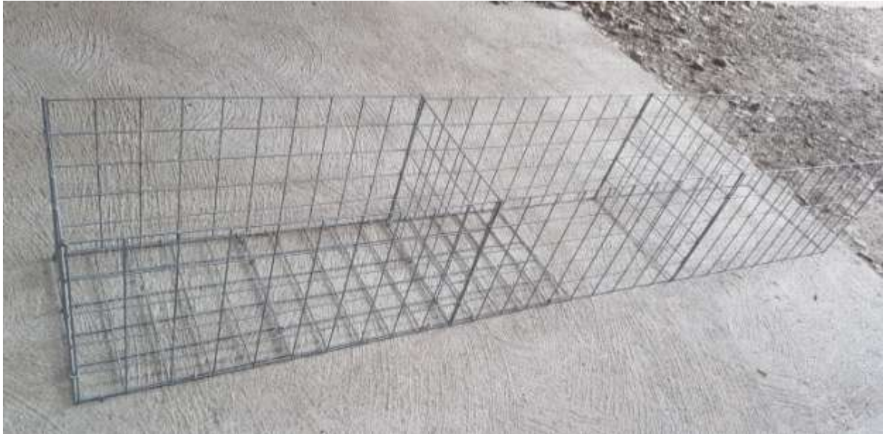
Abbildung 34 zusammengesetzte Steinkörbe (Melanie, 2017/18)
