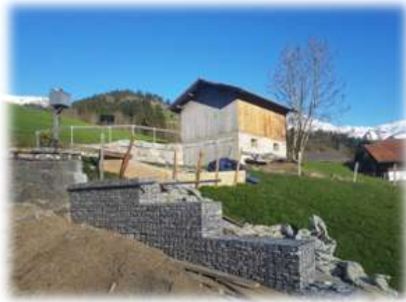
Abbildung 40 Endprodukt Steinkorbmauer Hausseite (Melanie, 2017/18)
