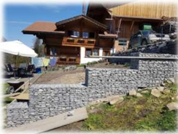
Abbildung 39 Endprodukt Steinkorbmauer Strassenseite (Melanie, 2017/18)
