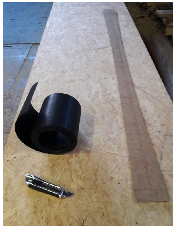
Abbildung 26 Belag zuschneiden, (Zahler, 2019)
