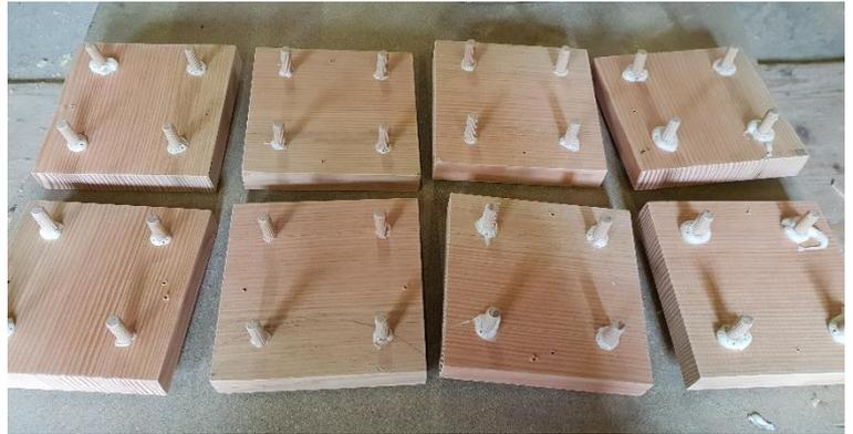
Abbildung 26 Tübel in die Eckpfostendeckel geschlagen
