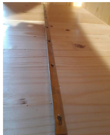
Abbildung 19 Hier nagle ich die Tragleisten an.
