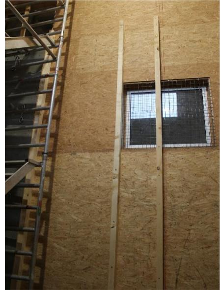
Abbildung 21 Der Rost hinter der Wand
