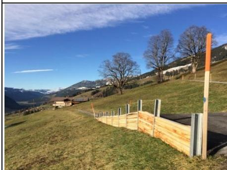
Abbildung 28 Holzabschrankung mit Eisenprofilen (Priska, 2020)
