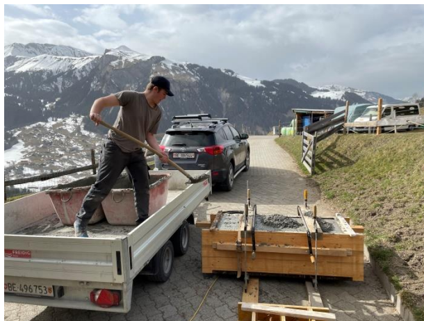
Abbildung 29 Hier sieht man mich wie ich den Beton in die Schalung schaufele. (Bowie, 2021)
