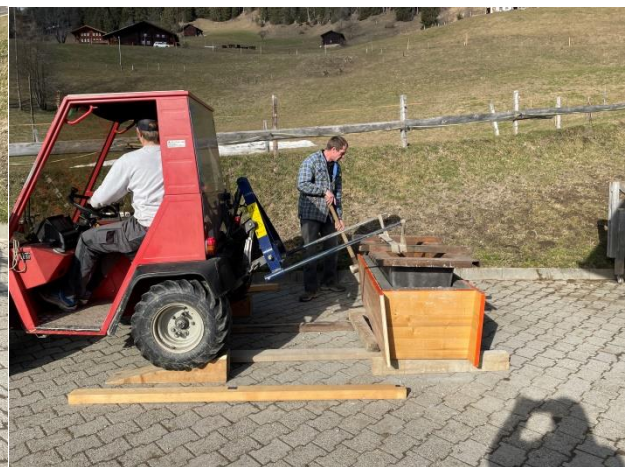
Abbildung 31 Auf diesem Bild sieht man mich und meinen Vater, wie wir die Innenschalung aus dem Brunnen nehmen. (Bowiee, 2021)
