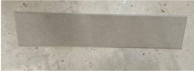
Abbildung 16 Hier sieht man die Einlagen für die Aussenschalung, damit der Brunnen seine schöne Form bekommt. (Bowie, 2021)
