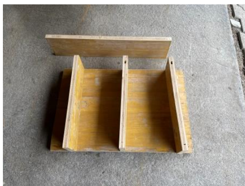
Abbildung 22 Hier sieht man die Schalung der Betonsockel. (Bowie, 2021)
