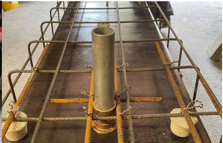
Abbildung 24 Auf diesem Bild sieht man den Auslauf vom Brunnen. (Bowe, 2021)
