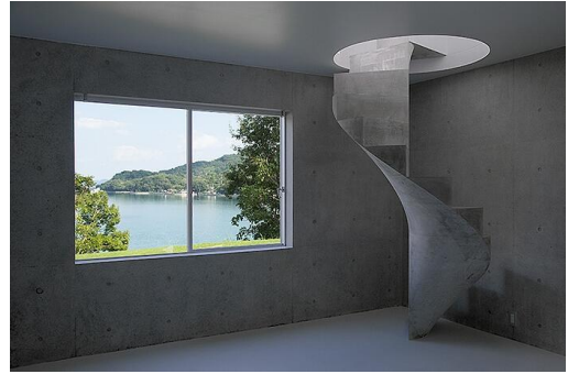
Abbildung 4 Hier sieht man eine Kreistreppe. Das ist der Beweis, dass Beton sehr formbar ist. (Allplan, 2021)
