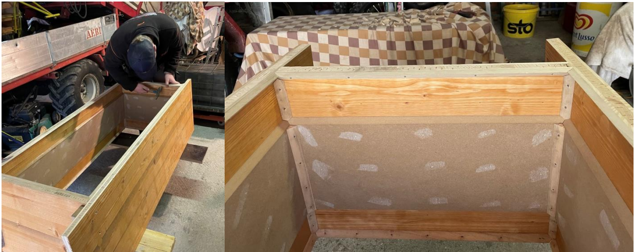
Abbildung 21 Auf diesem Bild sieht man mich, wie ich die Dreikantleisten an der Aussenschalung annagel. (Bowie, 2021)
