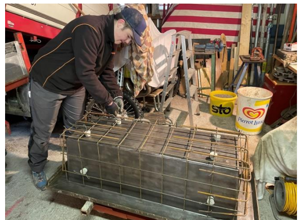
Abbildung 19 Hier sieht man mich, wie ich die Armierung zusammenbinde. (Bowie, 2021)
