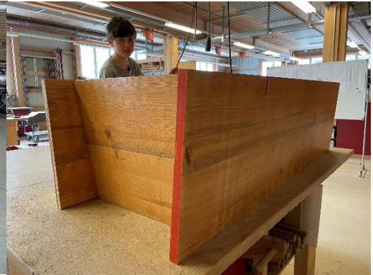
Abbildung 13 Auf diesem Bild sieht man die zusammengeschrubte Aussenschalung, bei der aber noch keine Einlagen darin sind. (Bowie, 2021)
