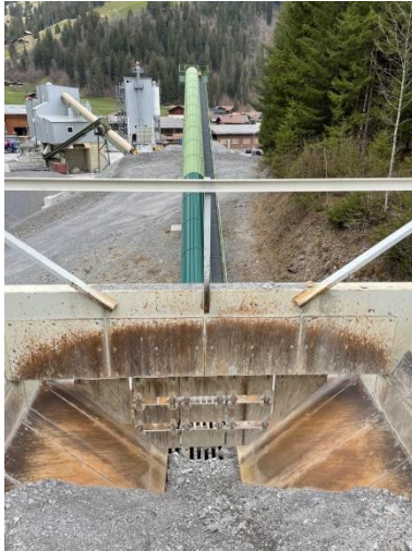
Abbildung 35 Hier sieht man den Trichter, in den der Schutt geschüttet wird. (Bowe, 2021)
