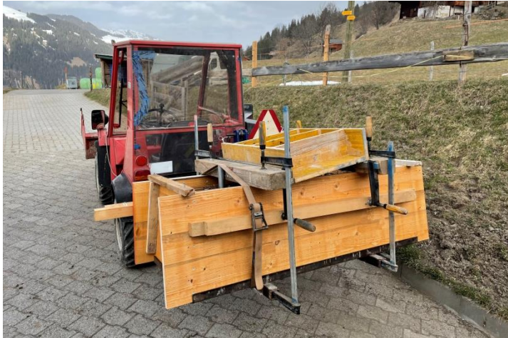
Abbildung 27 Auf diesem Bild sieht man, wie ich die Schalung transportiert habe. (Bowie, 2021)
