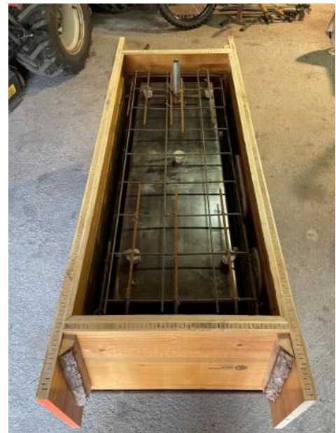
Abbildung 25 Hier sieht man die Schalung und die Armierung. (Bowe, 2021)
