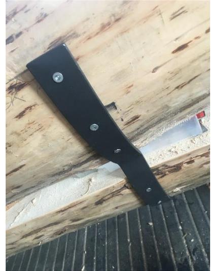
Abbildung 18 Der Lehn und die Lehn Halterung sind befestigt (Feuz, 2020)
