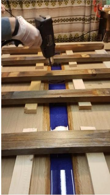
Abbildung 23 Mit dem Heissluftföhn, haben wir das Harz erhitzt
