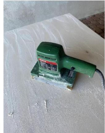
Abbildung 16 Man sieht die Handschleifmaschine, mit der ich die Grundplatte angeschliffen habe
