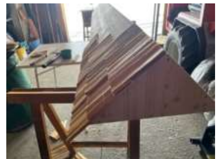
Abbildung 23 Angefangen zu Schindeln (Loris, 2022)
