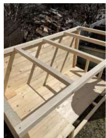
Abbildung 20 Holzlatten montieren
