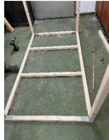
Abbildung 6 Kanthölzer befestigen (Boden)
