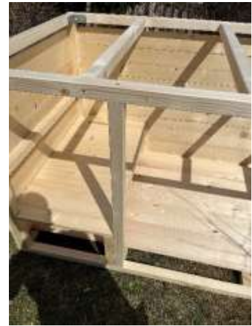
Abbildung 21 Kantholz für Gitterdraht
