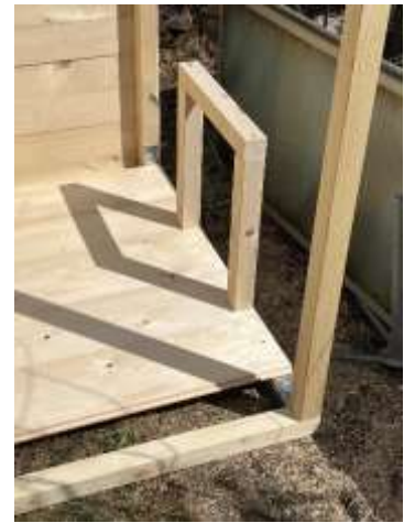
Abbildung 18 Einmitten der U Form
