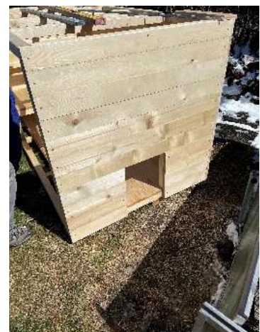
Abbildung 19 Verkleidete Rückwand fertig
