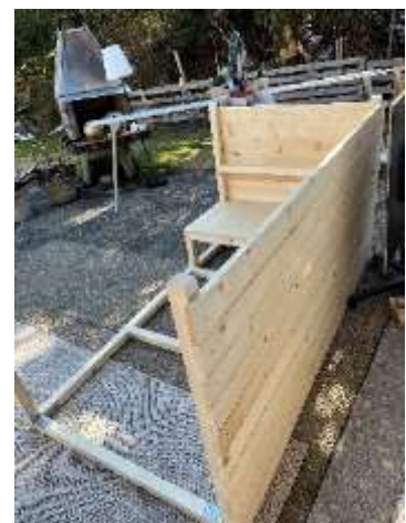
Abbildung 14 fertige Verkleidung der 2 Seitenwände
