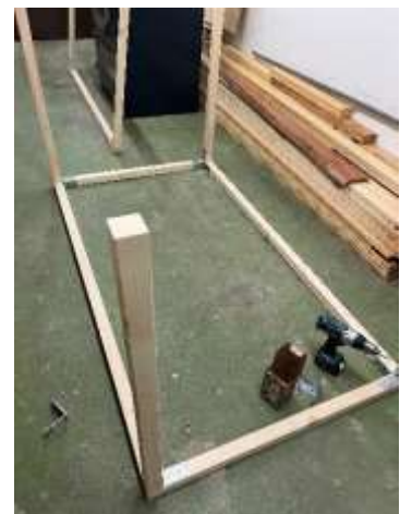
Abbildung 4 Kanthölzer anschrauben
