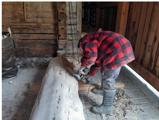
Abbildung 18: Splintrückstände mit Winkelschleifer abschleifen
