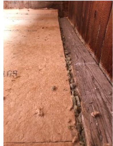
Abbildung 12, rund um die Isolationsplatten isolieren, Leonie Trachsel, 2023
