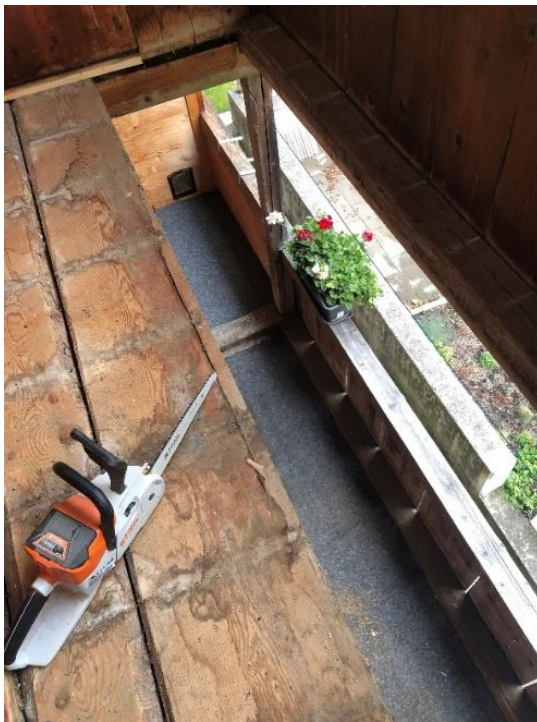
Abbildung 6, Holzbretter vom Boden wegsägen, Leonie Trachsel, 2023
