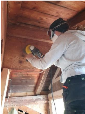
Abbildung 16, First bürsten, Leonie Trachsel, 2023
