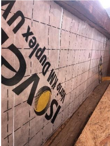
Abbildung 13, Windschutzfolie am Balkongeländer, Leonie Trachsel, 2023
