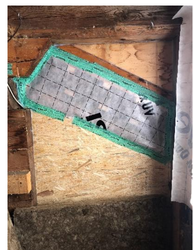
Abbildung 20, Seitenwand links isolieren, Leonie Trachsel, 2023
