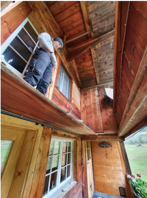
Abbildung 35, Baustellen Besichtigung, Leonie Trachsel, 2023
