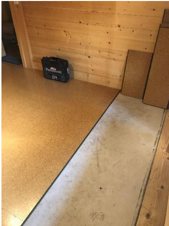
Abbildung 32, Alter Boden weggenommen, Leonie Trachsel, 2023
