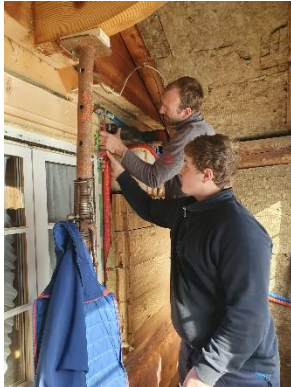
Abbildung 21, Heizungs- monteure, Leonie Trach- sel, 2023
