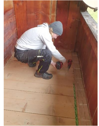
Abbildung 4, Holzbretter wegschrauben, Leonie Trachsel, 2023
