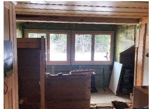
Abbildung 27, Alte Wand weggerissen, Leonie Trachsel, 2023
