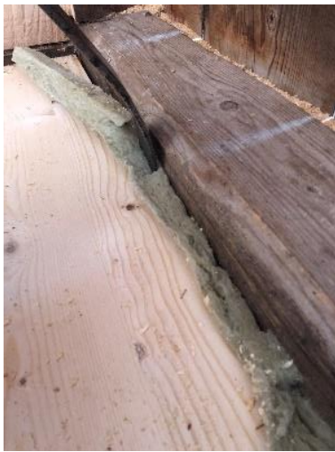
Abbildung 11, rund um die Bodenplatte isolieren, Leonie Trachsel, 2023
