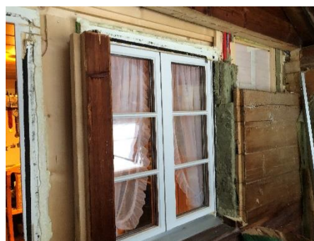
Abbildung 37, alte Wand abbauen, Leonie Trachsel, 2023
