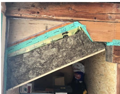
Abbildung 19, Seitenwand rechts isoliert, Leonie Trachsel, 2023
