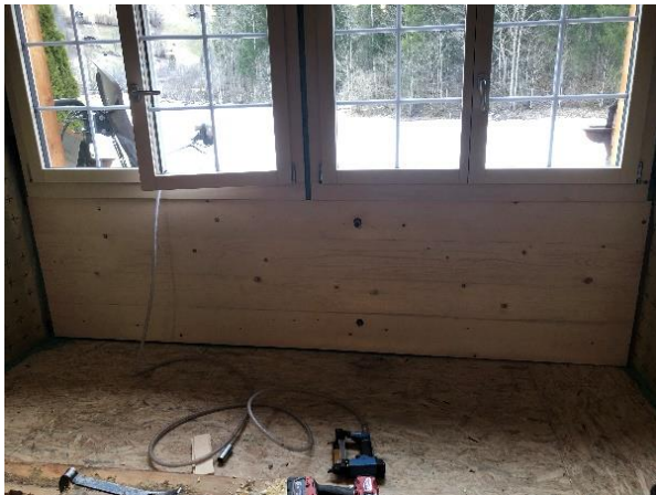
Abbildung 28, unter den Fenstern getäfert, Leonie Trachsel, 2023
