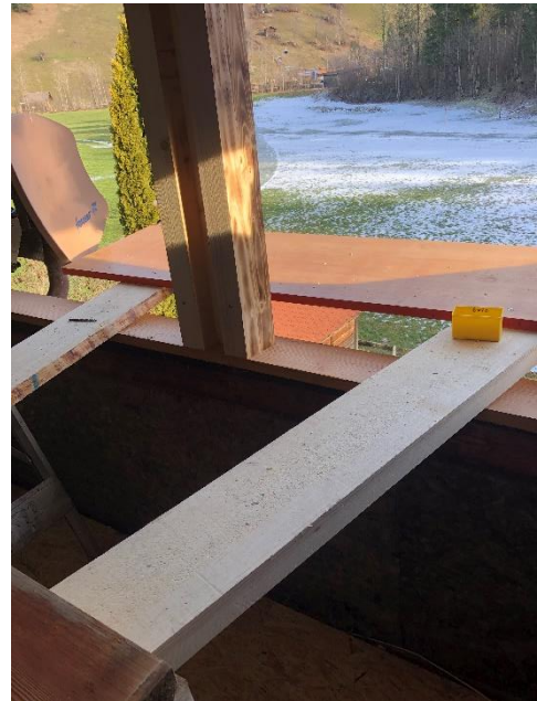
Abbildung 36, selbstgebautes Gerüst, Leonie Trachsel, 2023
