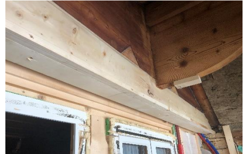
Abbildung 25, Stützbalken eingeführt Leonie Trachsel, 2023
