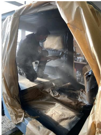
Abbildung 61 Hier ist er daran den Innenraum komplett zu spritzen
