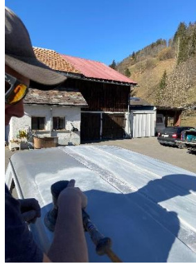
Abbildung 53 Hier wird das Dach geschliffen
