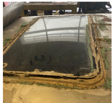
Abbildung 20 Das verklebte Dachfenster
