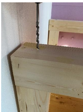
Abbildung 43 Löcher vorbohren
