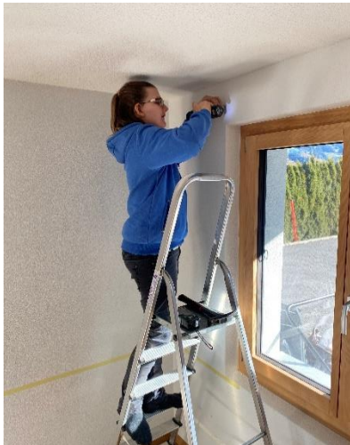
Abbildung 24 Löcher in die Wand bohren
