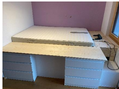
Abbildung 49 Platte zwischen den Kommoden befestigen
