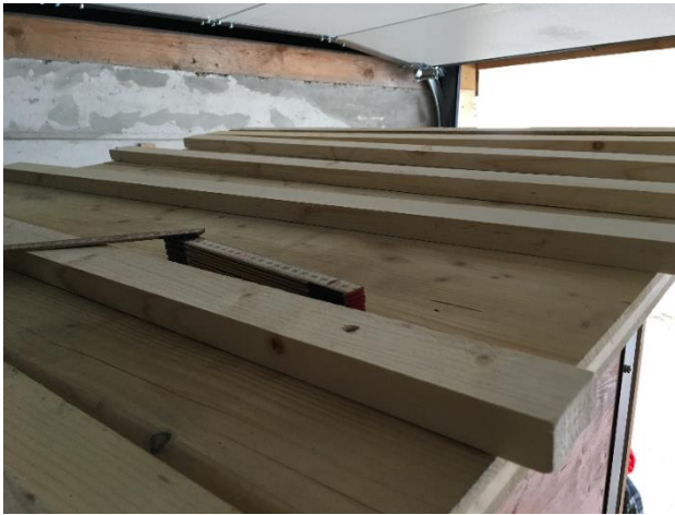
Abbildung 11 Angebrachte Dachlatten
