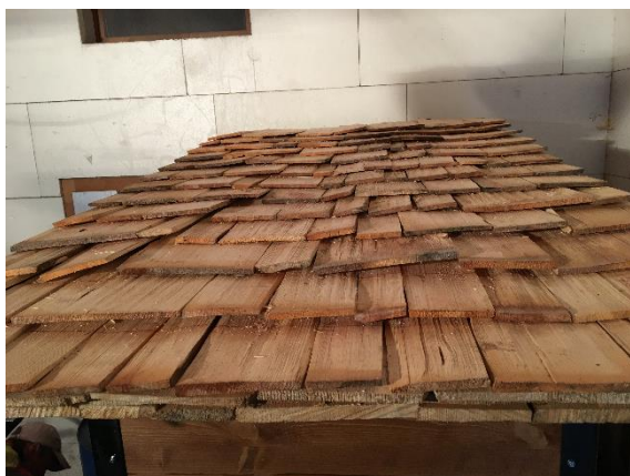
Abbildung 14 Schindeldach
